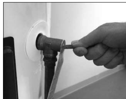
Figure 45 - Soupape de décharge à sécurité thermique
