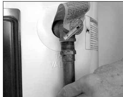
Figure 15 - Le tuyau d'évacuation de la soupape de décharge DST doit être installé correctement et canalisé à un drain adéquat.
