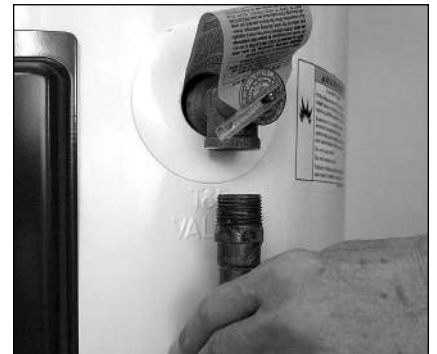
Figure 12 - Enlever le tuyau d'évacuation de la soupape de décharge DST.
