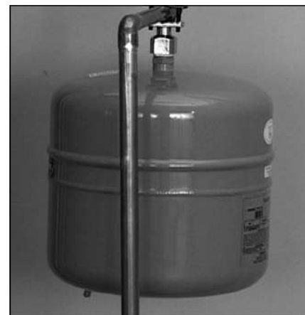
Figure 7 - Un réservoir de dilatation thermique aide à protéger le système de plomberie de votre domicile des pointes de pression.
