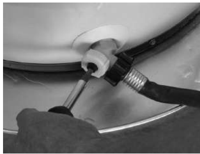
Figure 11 - Vidanger l'ancien chauffe-eau.
