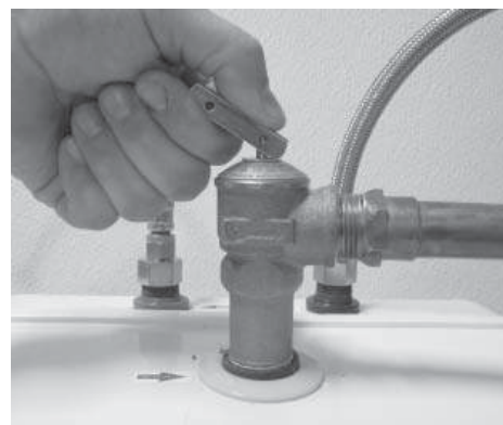
Figure 31 - Soupape de décharge à sécurité thermique
