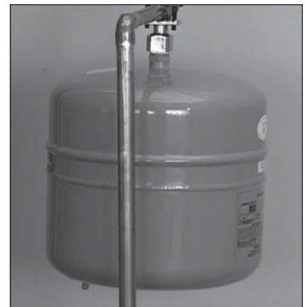
Figure 5 - Un vase d'expansion thermique aide à protéger le système de plomberie de votre domicile des pointes de pression.
