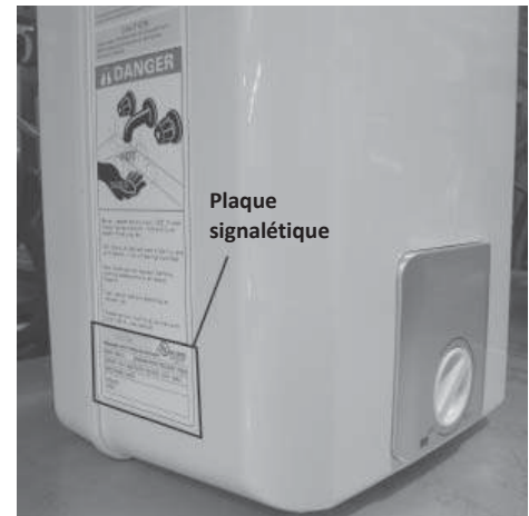
Figure 17 - Les exigences électriques du chauffe-eau peuvent être déterminées à partir de la plaque signalétique.
