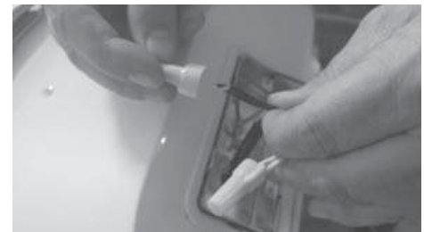
Figure 18 - Connecter les fils électriques.
